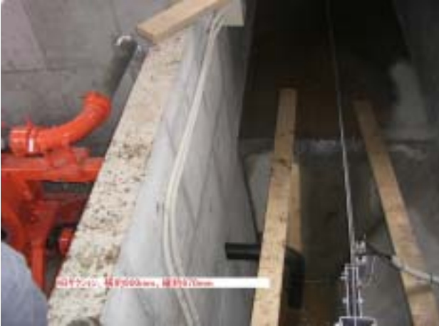
ポンプ設置状況
